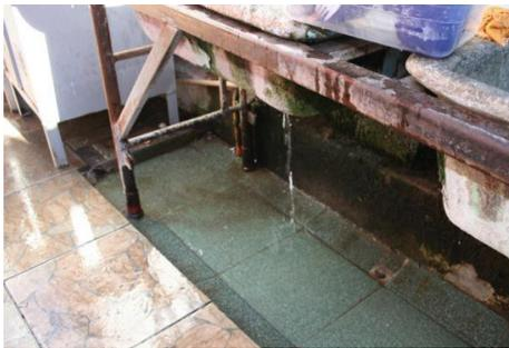
**FIGURA 7** Filtraciones de agua en módulo de mujeres. Fuente: INDH.
