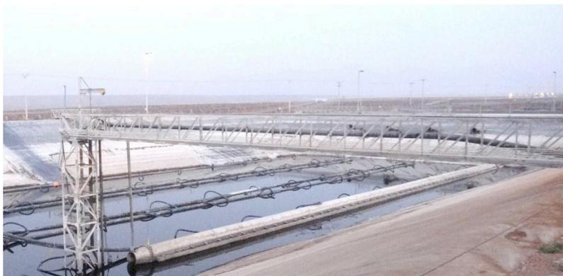
**FOTO 11** Laguna aeróbica en proceso de reparación en el sector de Maitencillo. Fuente: INDH
