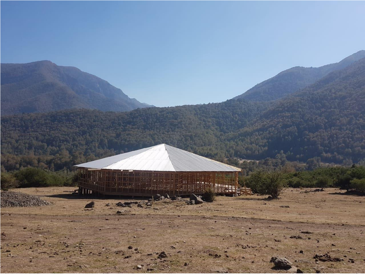
(Escuela Autónoma de Malla Malla, en construcción)
