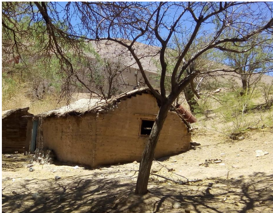
Fotografía INDH. En primer plano, la casa que debió abandonar una de las familias integrantes de la comunidad indígena colla, en segundo plano una de las edificaciones del campamento minero Caserones.
