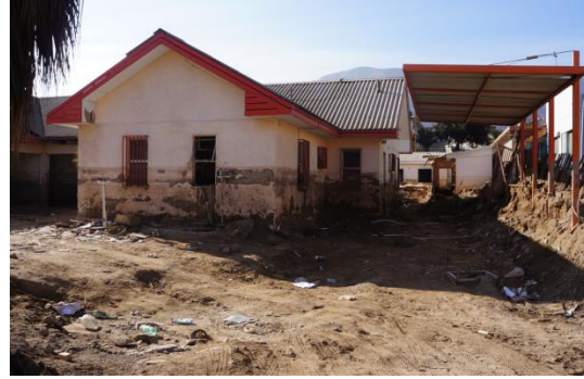
Figura 8: Imagen muestra daños que aún persisten en Chañaral.
