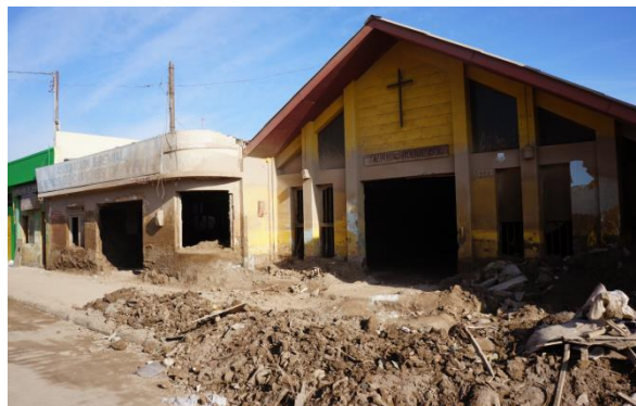
Figura 2: Imagen muestra daños que aún persisten en Chañaral
