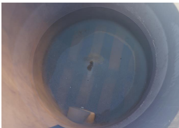
Figura 15: Interior de contenedor de agua donde se puede apreciar basuras y residuos de extraña apariencia. Fuente: Instituto Nacional de Derechos Humanos
