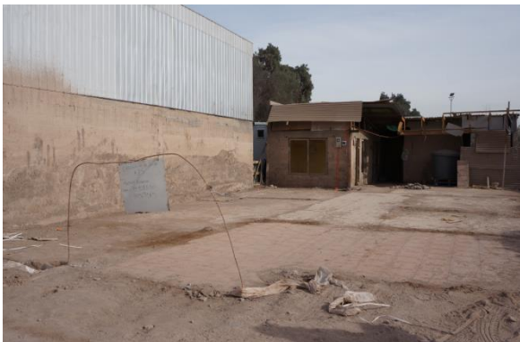
Figura 11: Imagen muestra sitio que permanece desocupado esperando autorización para reconstruir – Paipote.
