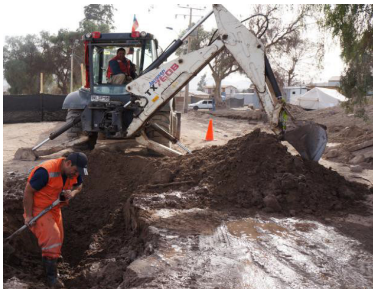
FIGURA 16 Retroexcavadora realiza trabajos de limpieza en Paipote. Fuente: INDH
