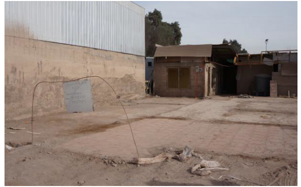
FIGURA 11 Imagen muestra sitio que permanece desocupado esperando autorización para reconstruir – Paipote. Fuente: INDH.
