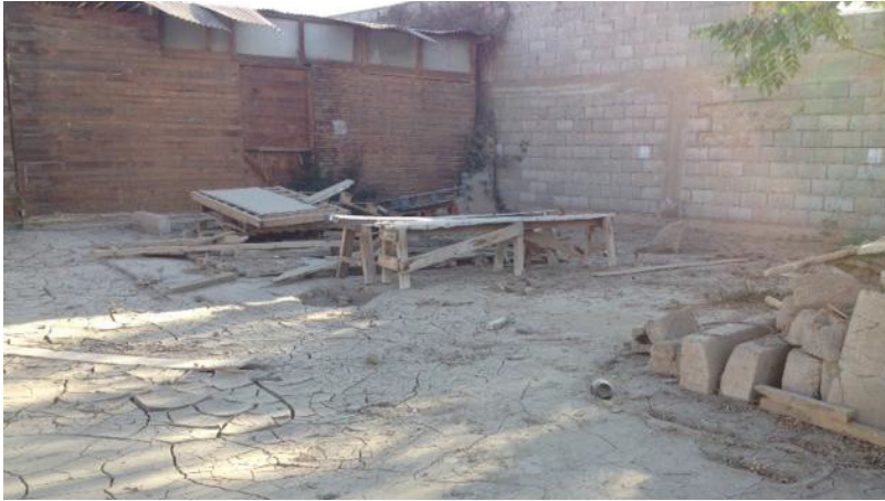
FIGURA 1 Imagen muestra la altura a la que llegó el lodo durante el 25M en Copiapó. Fuente: INDH.
